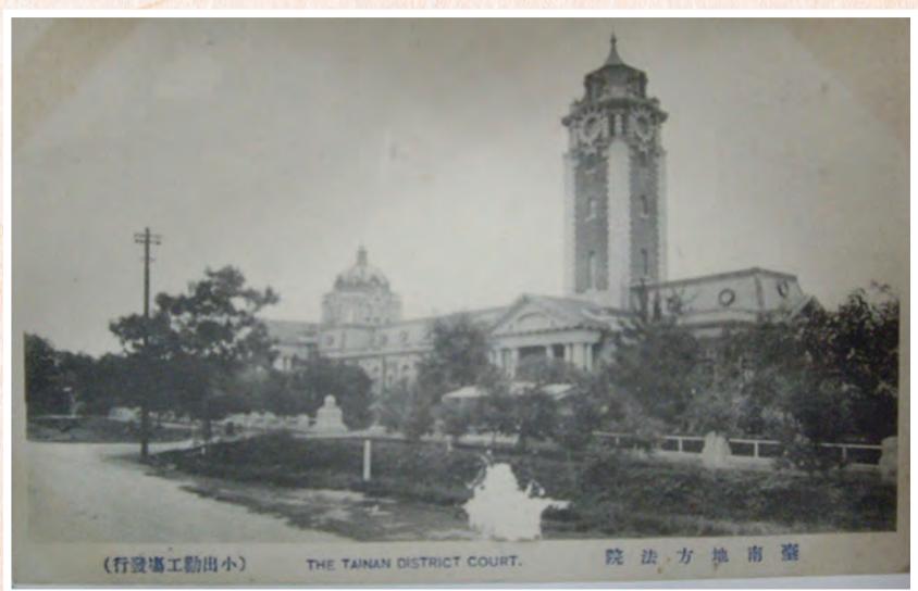
日據時代臺南地院建築外觀照片 日本明信片上印製圖樣
